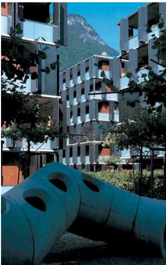
Внешняя облицовка стен медными изделиями Nordic Brown. Многоквартирный дом. Инсбрукский университет, Австрия.
