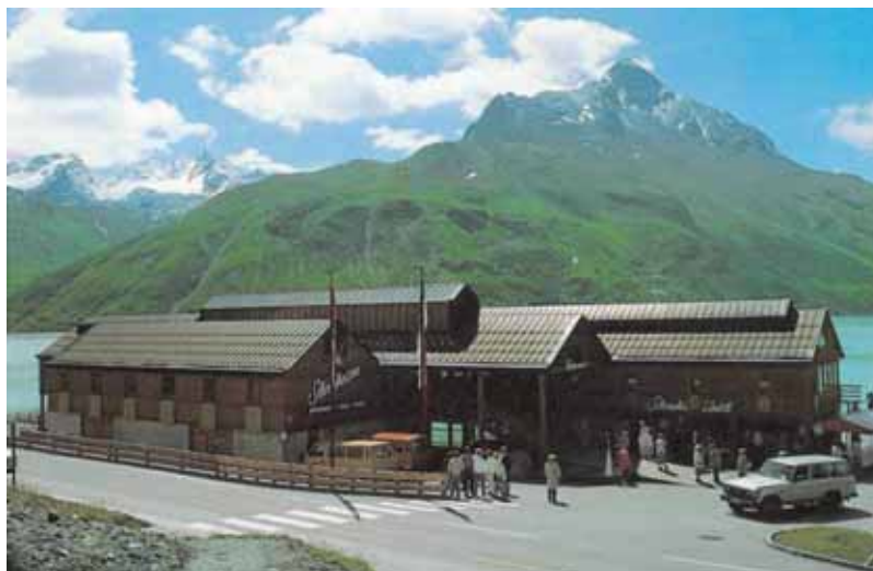
Защита от снежного оползня над входом
