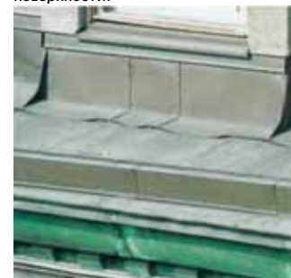
Широкий профилированный молдинг фасада, оснащенный водосточным желобом для отвода воды. Профилированные элементы такого вида изготавливают таким же образом, как и кровельные покрытия.
