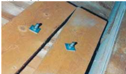
Правильно ли установлены крепежные элементы?
