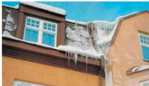
Внутренние напряжения, вызванные льдом и действующие на карниз, коробчатый водосточный желоб и водосточную трубу.
