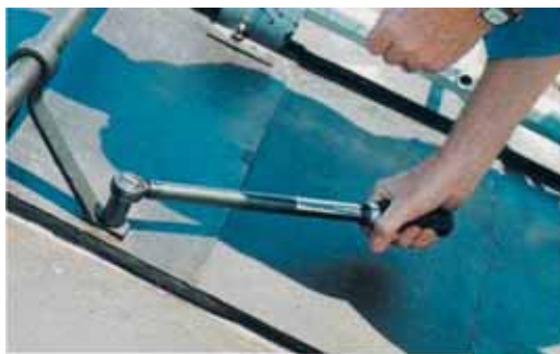
Крепления предохранительных устройств в деревянных основаниях крыши всегда должны быть затянуты. Фальцевые соединения, с другой стороны, не следует затягивать.
