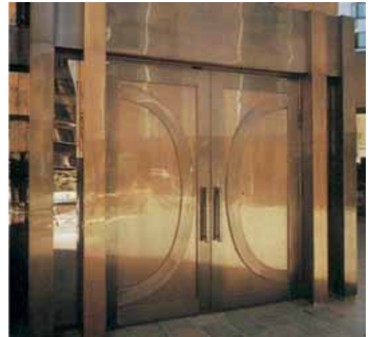
Лакирование светлым лаком на входной двери
