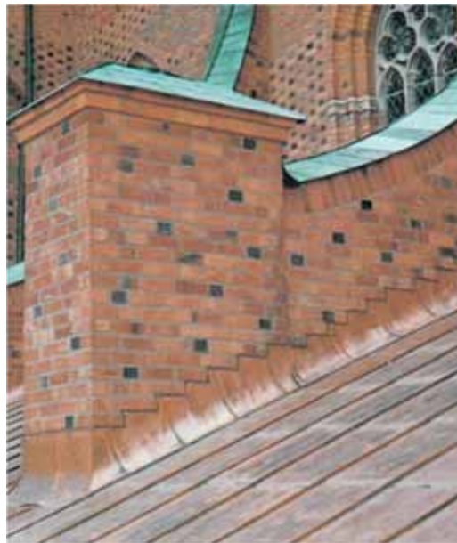
Осматривая вертикальные отливы (фартуки) необходимо проверить их крепеж: и герметичность, выявить места коррозионного повреждения, повреждений, вызванных тепловым расширением, и механических повреждений.
