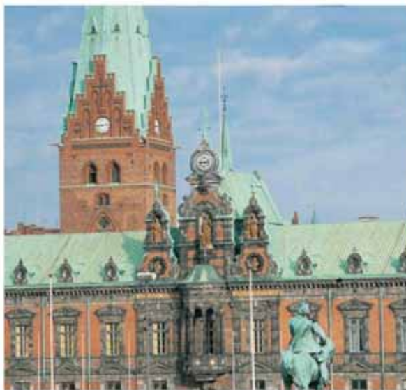
Медные кровельные покрытия имеют несравнимый ни с чем срок службы. Никто не знает, каков возраст может достигнуть медная кровля. Фотография ратуши в Мальме, Швеция.
