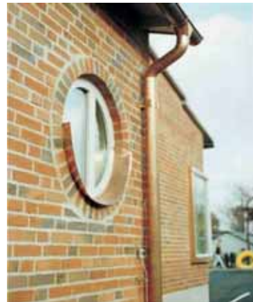
Прикреплен ли к стене элемент соединения водосточной трубы?
