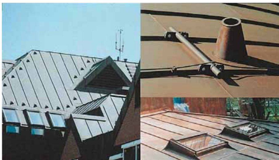
Размещение мест проникновения в крышу должно быть отмечено на плане
