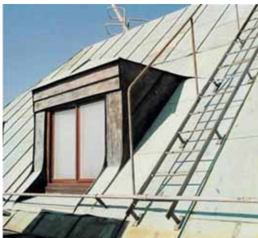
Проверка предохранительных устройств на крыше - жизненно необходимая часть процедуры осмотра во время технического обслуживания.
