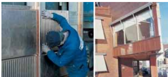
Монтаж медных кассет
