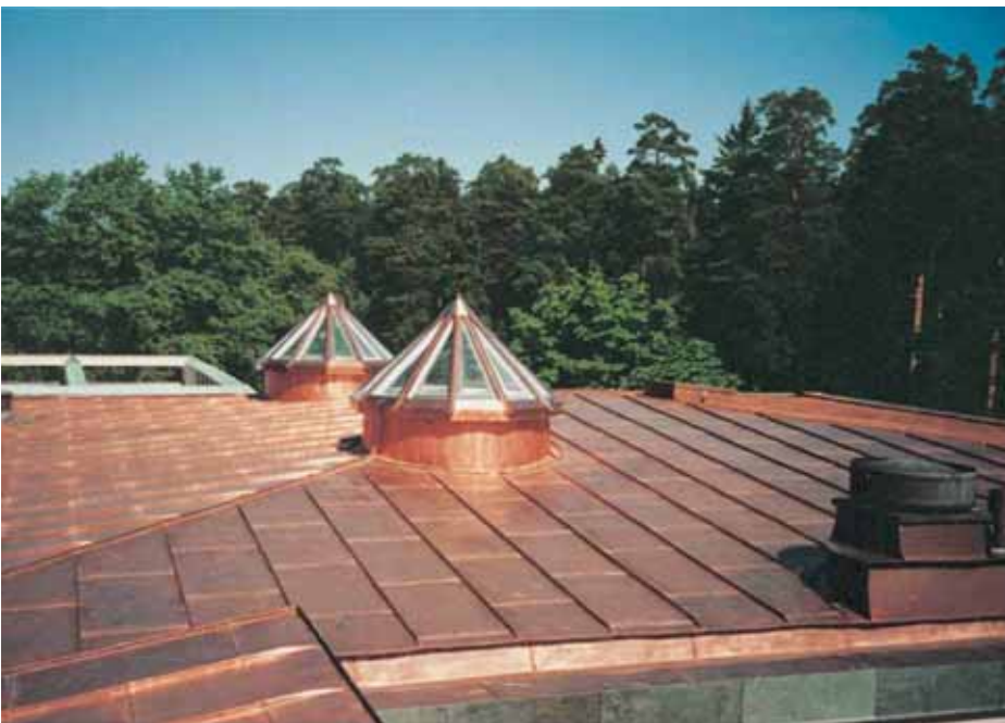
(медь, используемая для покрытия Тыш, чаще всего - это раскисленная осфористая медь.
