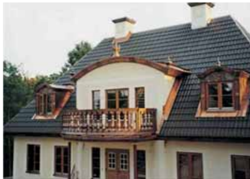
Покрытое медью окно мансарды
