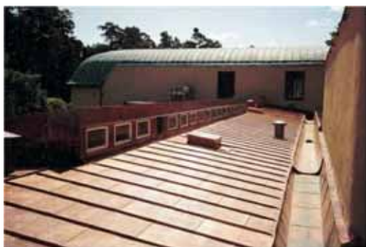
Красивую крышу имеет смысл поддерживать в хорошем состоянии
