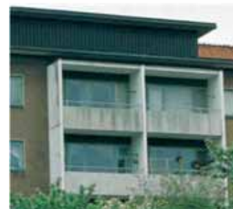
Вода, которая содержит медь, может вызывать выцветание и коррозионные повреждения светлой поверхности.
