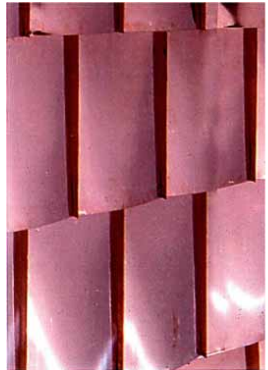
Медные кассеты с покрытием Nordic Quick , установленные на стене.
