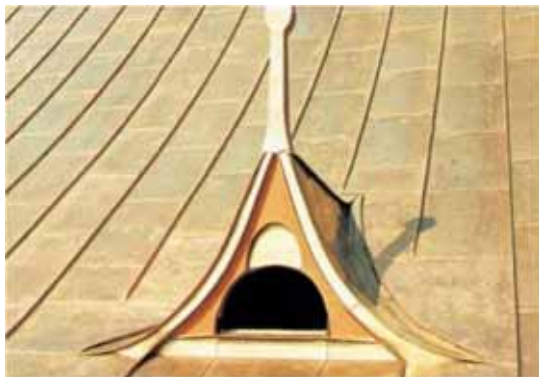
Следует проверить отлив на деталях, которые подвергаются напору ветра, особенно их крепеж.
