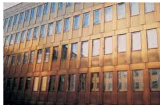
Кассеты, изготовленные из томпака – латуни, содержащей 80% меди и 20% цинка.
